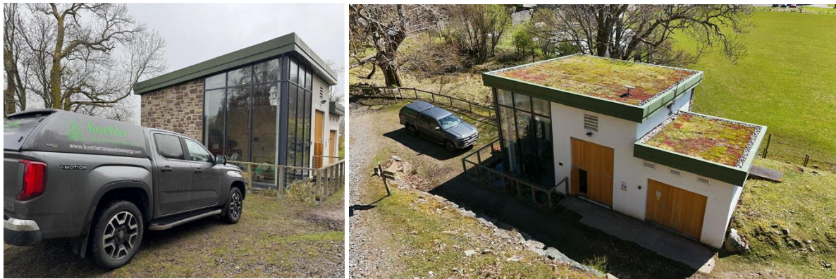
Abbildung: Wasserkraftanlage Allt Mor in Kinloch Rannoch, Perthshire. Quelle: Koehler Renewable Energy
