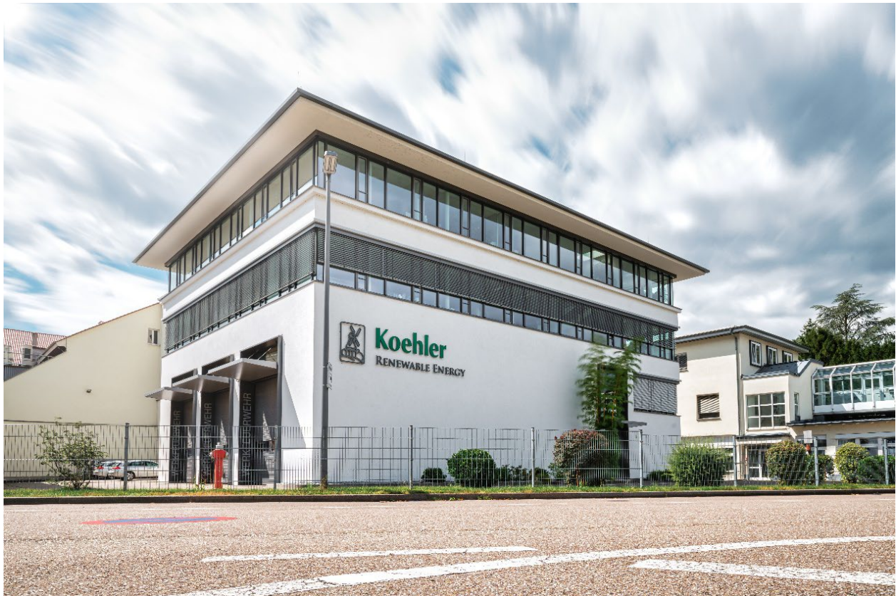
Abbildung: Mit Gründung von Koehler Renewable Energy im Jahr 2012 entstand auch der neue Bürokomplex in Oberkirch. / Bildrechte: Koehler-Gruppe
