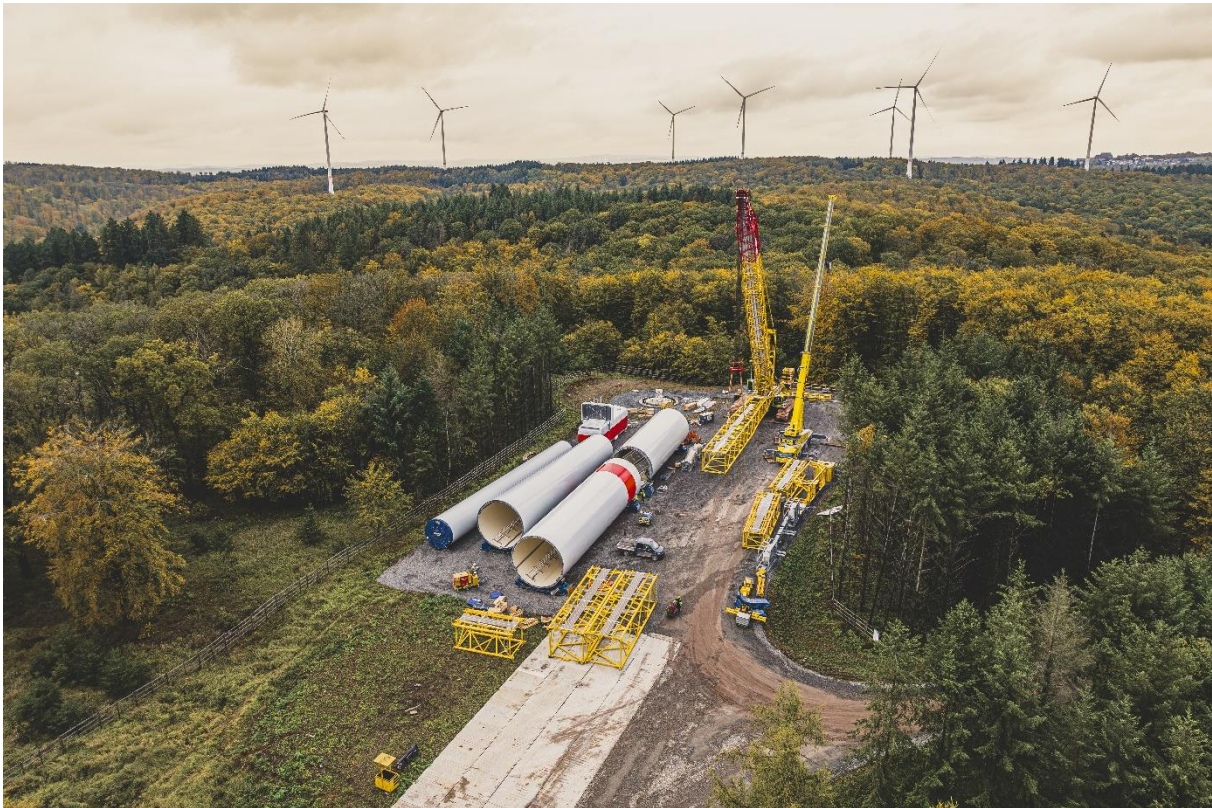
Abbildung: Mit einem Spezialkran werden die tonnenschweren Bauteile der Windkraftanlagen zusammengesetzt / Quelle: Koehler-Gruppe
